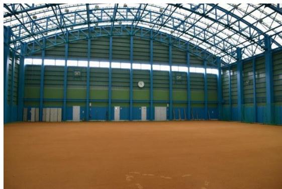
室内運動場新設
