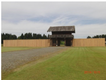
外柵南門・柵列（復元）・正面玄関の門は柱の直径60cmの八脚門
